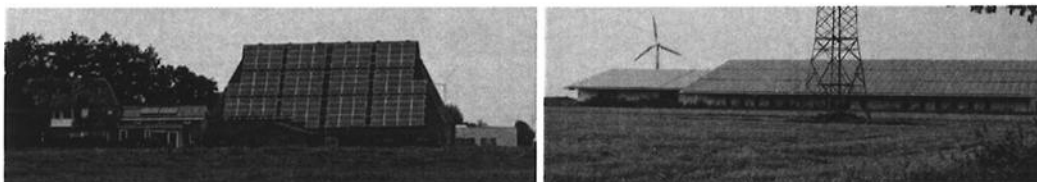
Losse panelen op een boerderijdak in Duitsland en een aaneengesloten panelen op het dak van een Duitse stal (beide foto's uit Sinnestroom, Atelier Fryslân)
